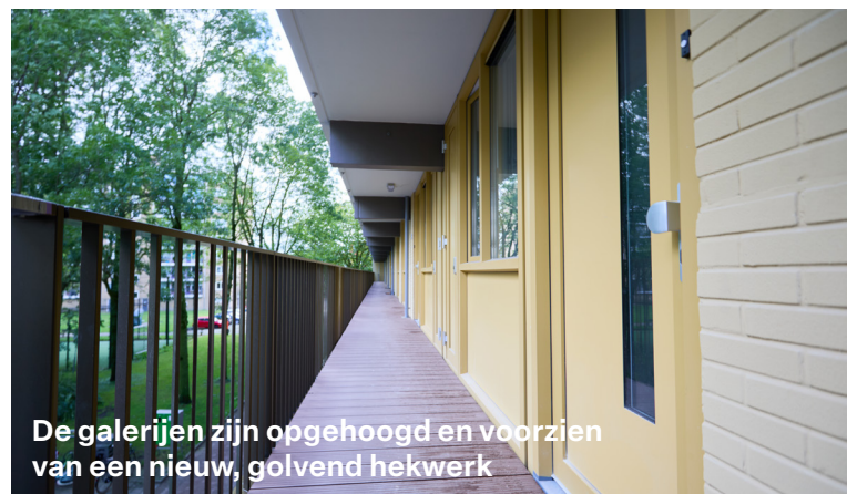
Op de begane grond is een extra brandtrap geplaatst
